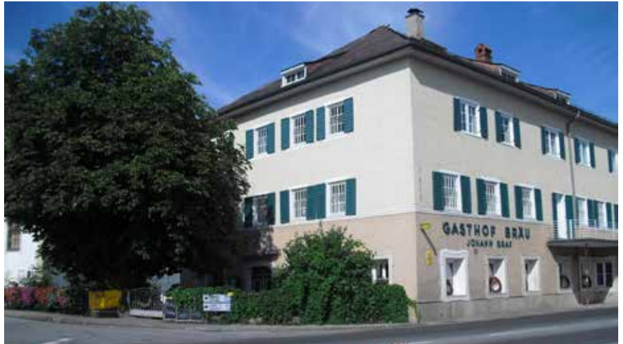
Es kommt Leben in das Bräu Gebäude! (Foto: Gemeinde)
